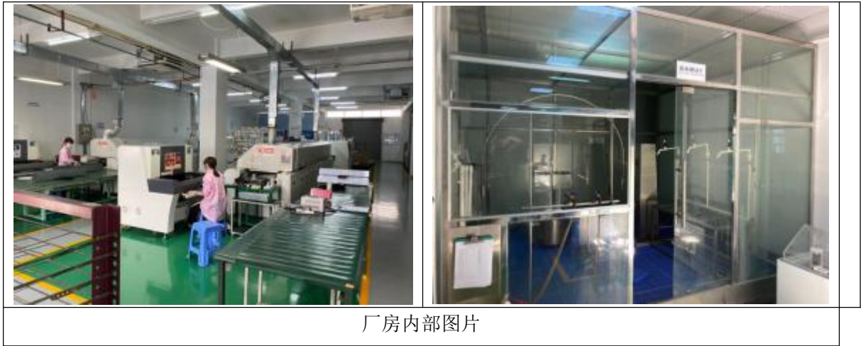
图3.2-2 厂房内部设备图
