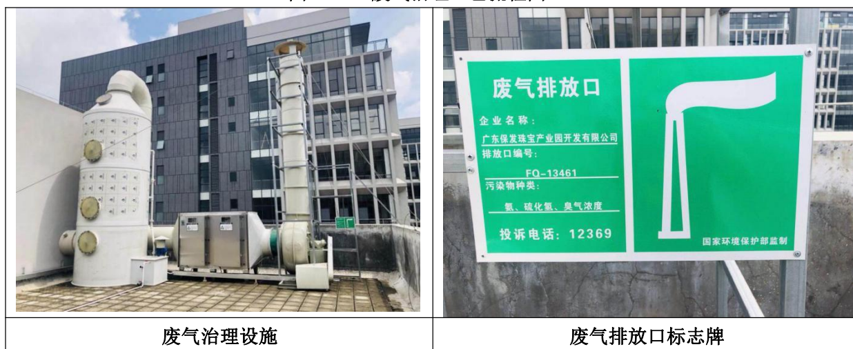
图 4.1-3 废气治理设施现场照片
