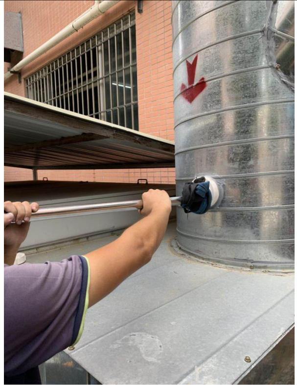
热熔、押出、注塑机热压废气处理前监测口 Q2-F
