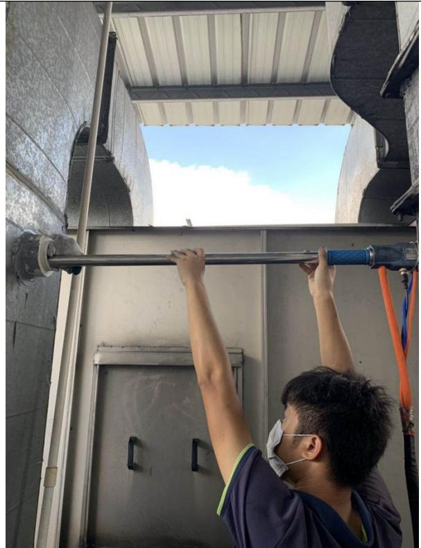
移印、喷漆及烘干废气处理前监测口 Q1-D
