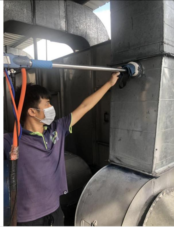
移印、喷漆及烘干废气处理前监测口 Q1-A
