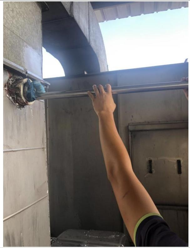
移印、喷漆及烘干废气处理前监测口 Q1-B
